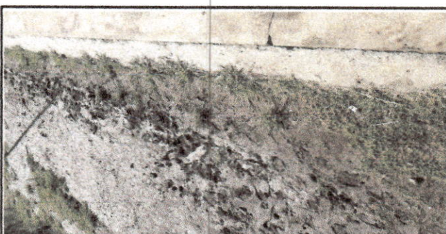
Foto 6: Reparación de planchas de concreto de patio
