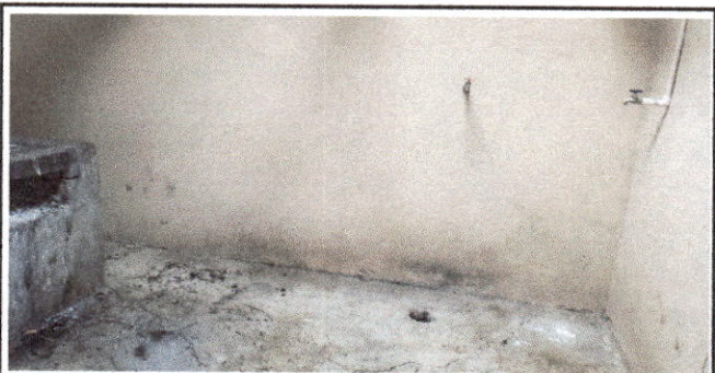
Foto 5: Instalación de pila
