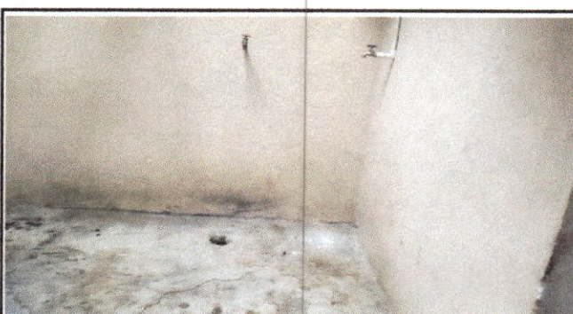
Foto 4: Instalación de pila
