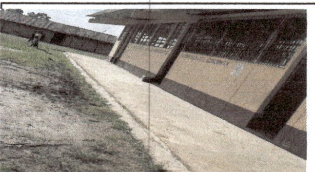
Foto 4: Reparación de planchas de concreto de patio
